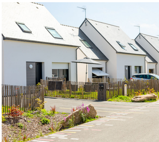
Éco-quartier à Trégunc composé de logements locatifs sociaux et en accession sociale à la propriété
