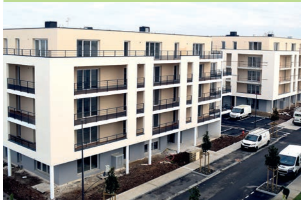
SULLY - RUE ALPHONSE ARZEL 26 logements collectifs Architecte : François Mysliwicks
