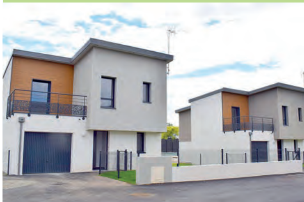
IMPASSE MARGUERITE CHABAY 12 logements individuels en PSLA Architecte : Y. Duval
