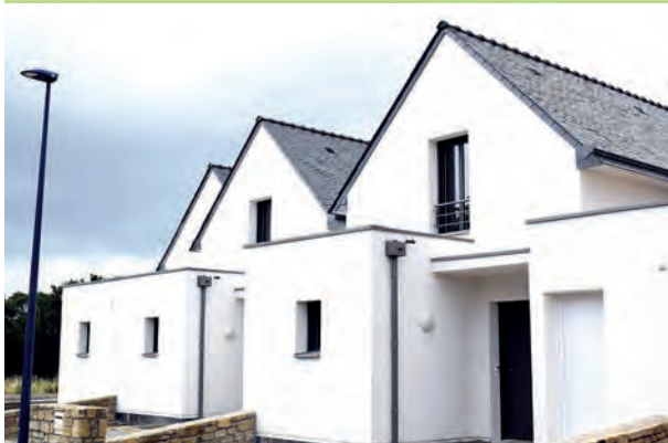
IMPASSE DU LETTY 3 logements individuels Architecte : Hubert Le Quéau
